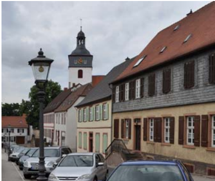
Abb. 35 Gebäude Amtsstraße 7 mit massivem Erdgeschoss und verschieferten Fachwerk im OG
