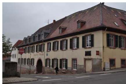
Abb. 37 Gebäude Amtsstraße 27/29 massiver Putzbau mit Fensterläden
