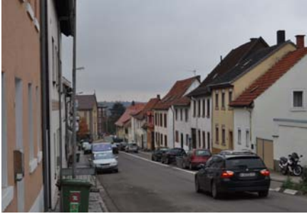
Abb. 48 Gebäude in der ansteigenden Breitstraße
