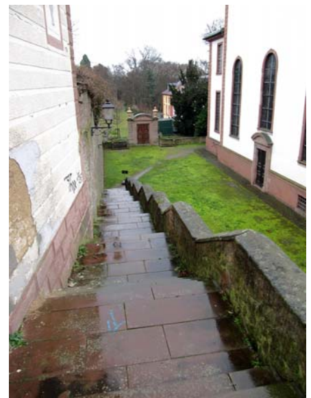
Abb. 83 Treppenanlage an der Langen Bahn
