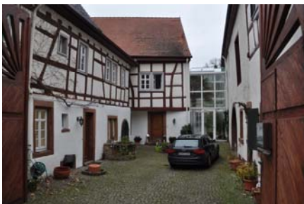
Abb. 73 Bsp. für gelungene Sanierung
